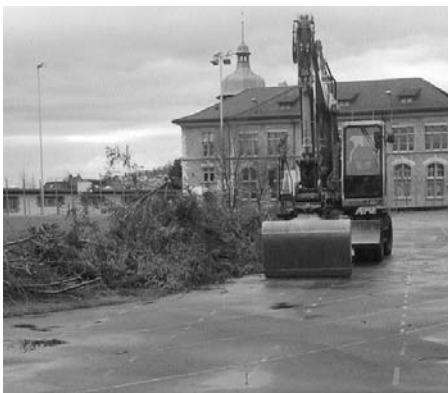
11. März 2013: Die ersten Bagger fahren auf.
